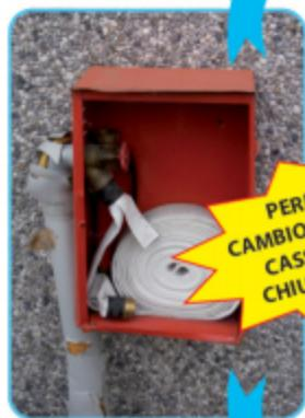
Togliendo le lamierette pretagliate sul lato e sul retro della cassetta la si può installare con la tubazione all'esterno della stessa senza dover smontare il rubinetto.
